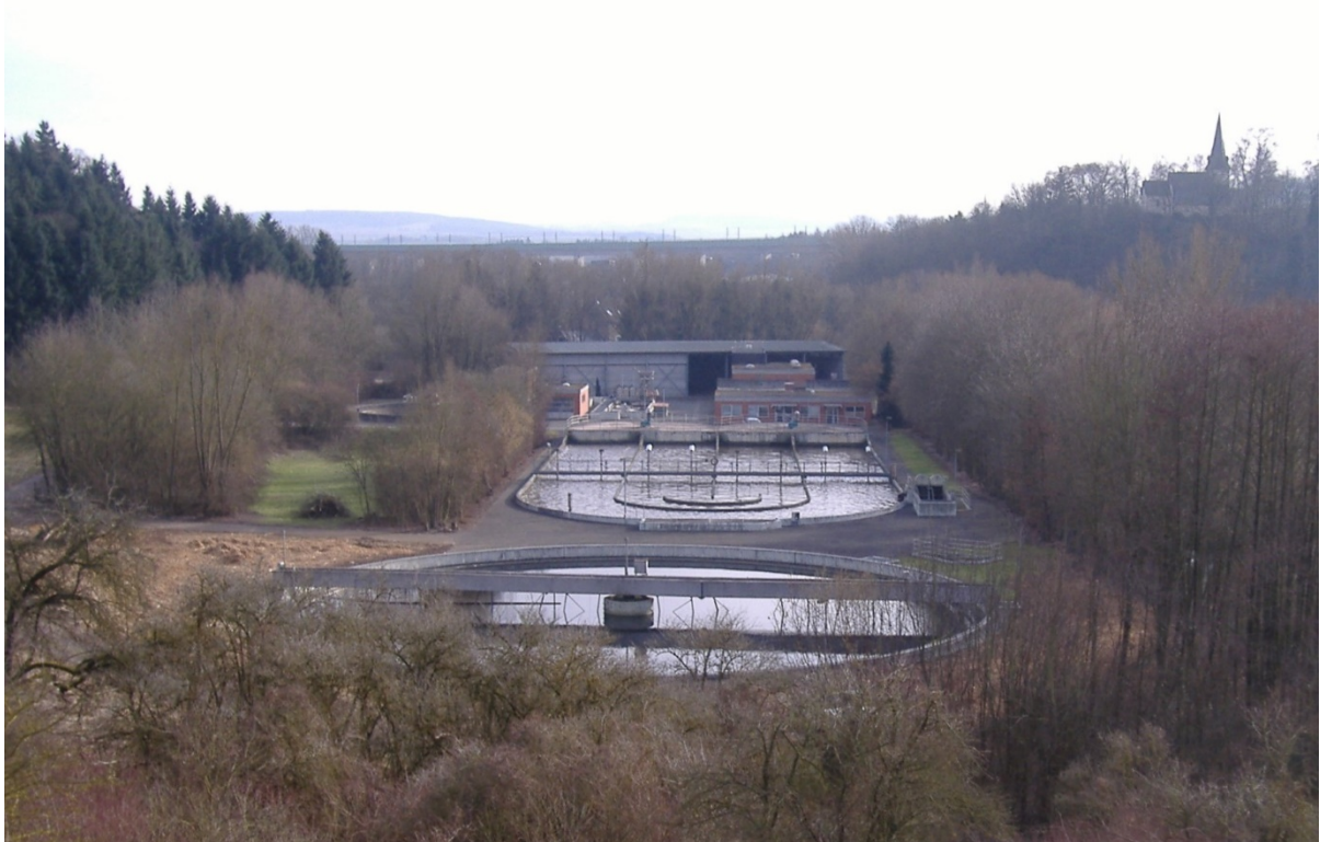
Bild 1: Kläranlage Niederbrechen (heute), rechts hinten: Berger Kirche
