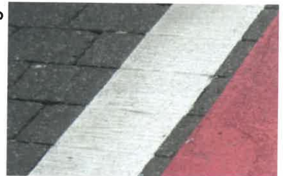
Beispielfoto: Markierung mit Kaltplastikmasse
