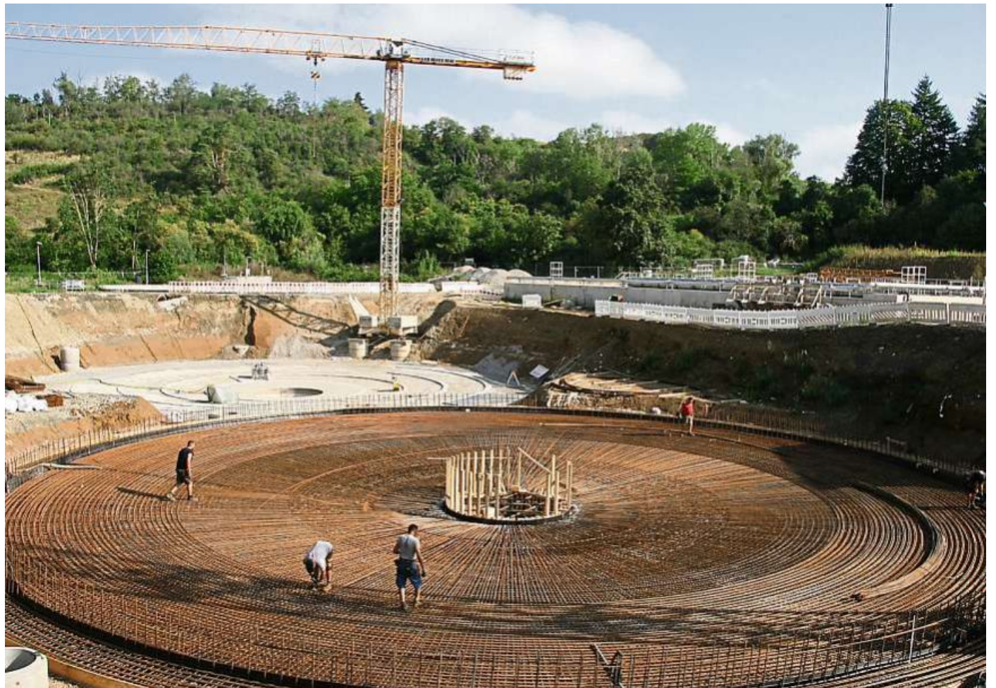
Auf diesen kreisrunden „Töpfen“ entstehen die beiden neuen Nachklärbecken.
