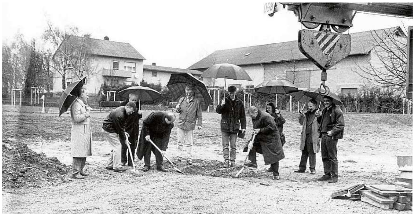
Mit vereinten Kräften von Vertretern der Gemeinde und des Gemeinnützigen Siedlungswerks Frankfurt und dem Segen von Pfarrer Harald Drechsler (Dritter von links) begann vor 27 Jahren mit dem ersten Spatenstich oberhalb des Niederbrechener Sportplatzes der Bau des Seniorenzentrums Brechen. Fotos: Ursula Königstein
