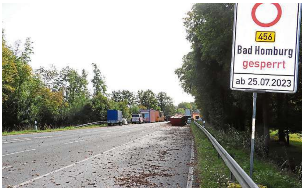
Auch auf der Bundesstraße 456 wird schon seit den Sommerferien gearbeitet. Ende Januar soll die Sperrung aufgehoben sein. Foto: Henning Schenckenberg
