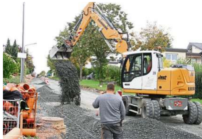
Im oberen Teil der Villmarer Straße ist der Bagger am Werk.
